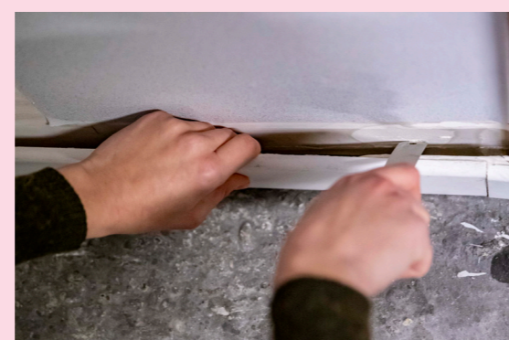
Déposer les plinthes Remove the plinths
