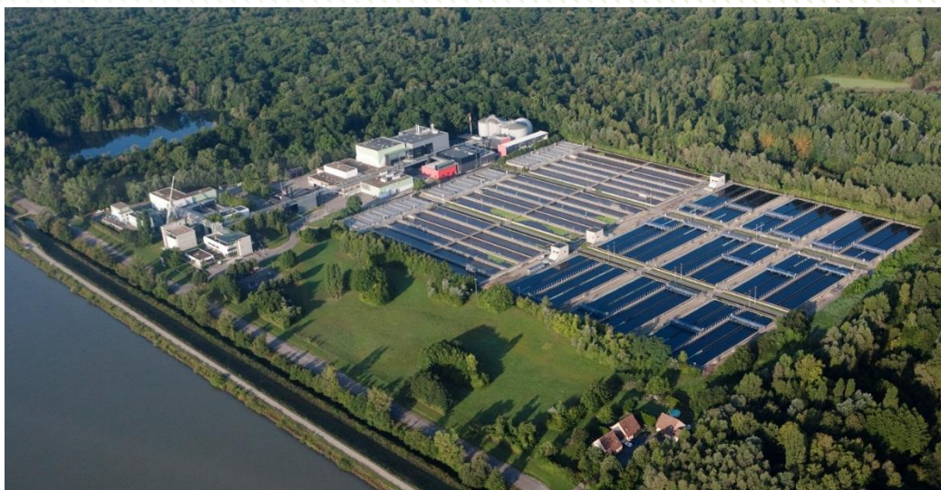
Station d'Épuration de La Wantzenau (photo J. Dorkel)
