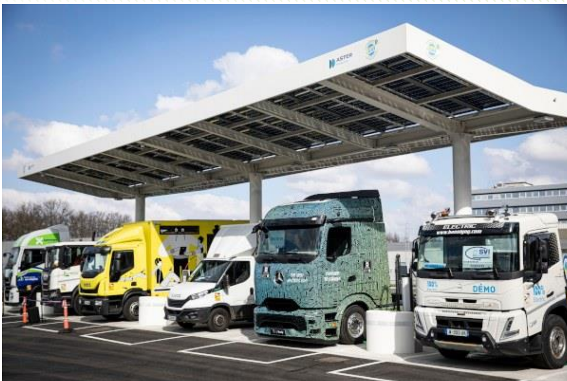
Station de la Plaine des bouchers (4 pistes Bio GNC à gauche et 2 points de recharge électrique à droite)
